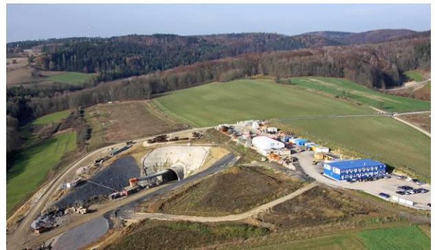
Voreinschnitt Süd und Baustelleneinrichtung
